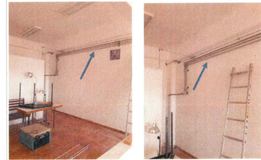
F31: Tendido de tuberías conduit para instalaciones eléctricas
