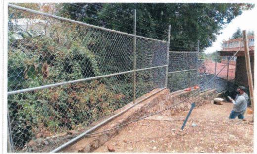
F21: Muro de contención con colocación de malla ciclónica.
