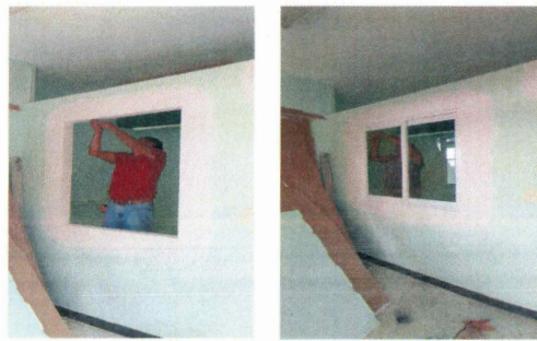
F12: Suministro y colocación de ventanas de aluminio blanco en oficinas.
