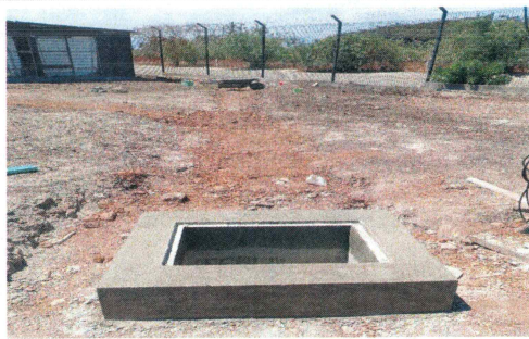
F35: Colado con concreto hecho en obra de cadena perimetral de registros sanitarios
