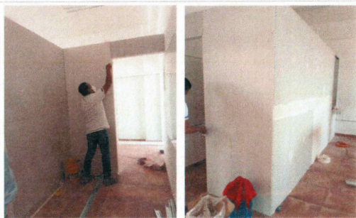
F11: Colocación de muros de tablaroca a dos caras
