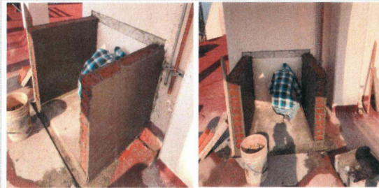
F9: Construcción de nicho para hidroneumático
