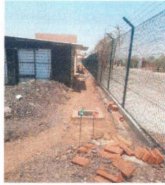
F8: Relleno y compactación de terreno en área de excavación
