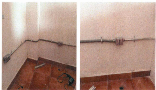
F17: Colocación de tubería de conduit para instalación eléctrica
