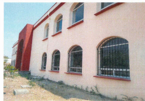
F21: Suministro y colocación de protecciones de herrería
