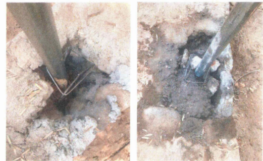
F18: Colado de castillos ahogados y postes de malla con concreto hecho en obra
