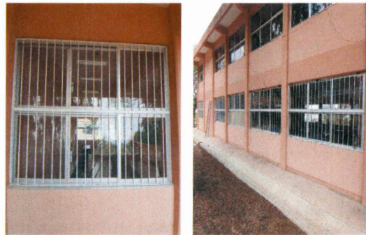
F17: Suministro y colocación de protecciones de herrería en aulas del edificio 10
