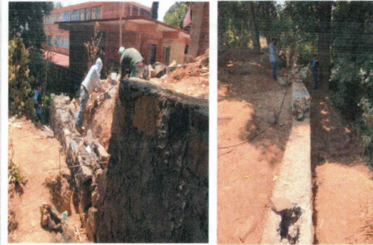
F6: Elaboración de muro de contención en límites de barranquilla
