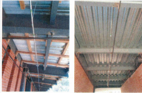
F24: Canalización para instalaciones eléctricas en pasillo
