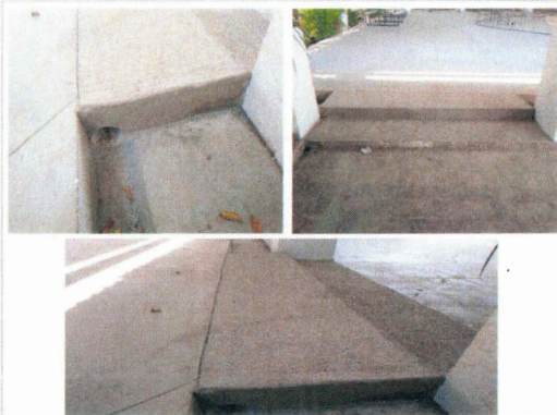
F30: Colado de escalon con concreto hecho en obra de acceso a cafeteria-explanada.
