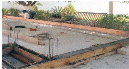
F9: Colado de cadena perimetral con concreto hecho en obra de templete en explanada.
