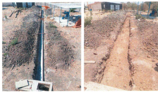
F36: Tendido de tubería de pvc sanitario, relleno y compactación de terreno en área de excavación
