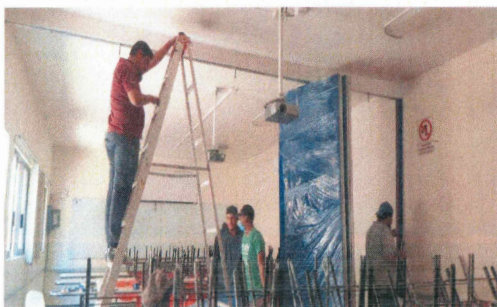
F10: Suministro y colocación de muro móvil
