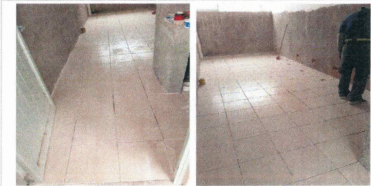
F24: Suministro y colocación de piso de loseta cerámica en sanitario de mujeres
