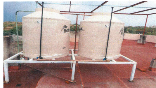
F39: Colocación y conexión de tinacos en losa de azotes.
