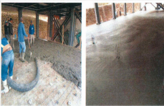
F19: Colado de firme con concreto premezclado f_c = 250 \text{ kg/cm}^2 en planta baja
