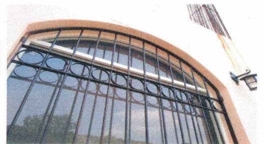
F20: Suministro y colocación de protecciones de herrería.
