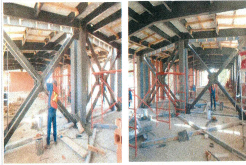
F6: Cambio de contraventes de acuerdo a cálculo estructural
