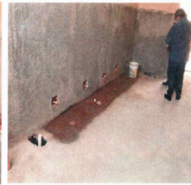
F11: Corrección de preparaciones hidrosanitarias existente en sanitarios de mujeres
