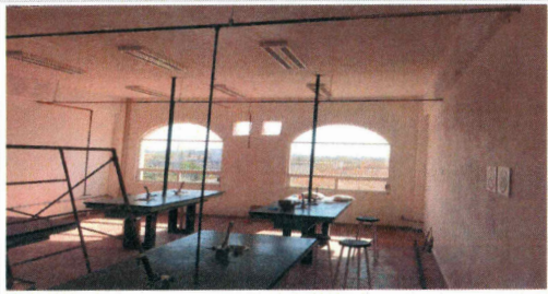
F8: Conexión de instalación de gas en mesas de laboratorio
