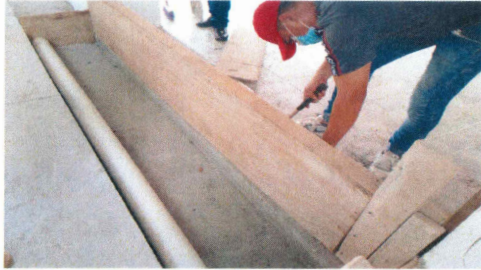
F5: Colocación de tubo pvc para agua pluvial y habilitado de cimbra para colado de escalon.
