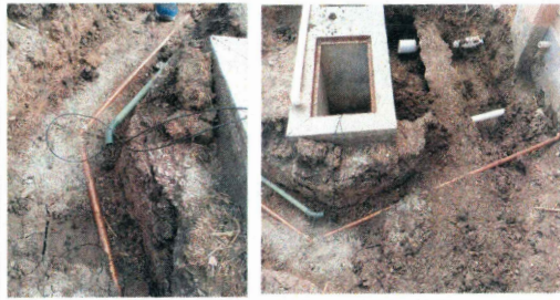
F17: Colocación de tubería de cobre y pvc pesado para conexión de tinacos
