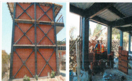
F22: Construcción de muros vintex
