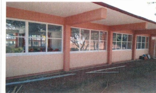
F18: Suministro y colocación de cancelería de aluminio de 2" en edificio 2.
