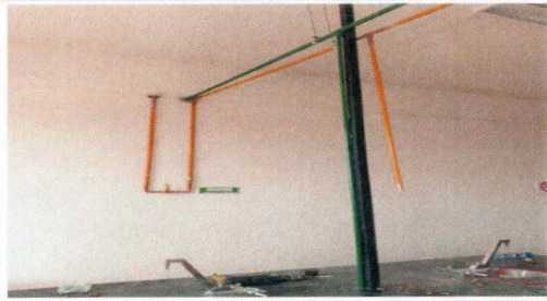
F6: Colocación de tubería de cobre para instalación de gas
