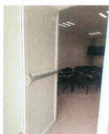
F14: Suministro y colocación de puerta de aluminio blanco con barra antipánico para salida de emergencia
