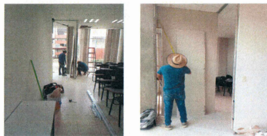
F10: Suministro y colocación de muro de tablaroca
