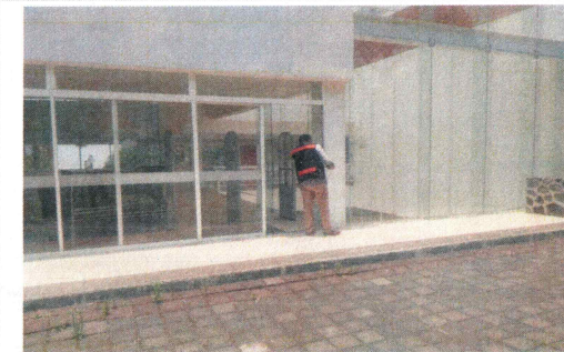
5.- En el acceso norte (acceso a segunda planta por estacionamiento) se colocará rejilla pluvial, se sustituirá cancel existente y se construirá rampa de acceso.
