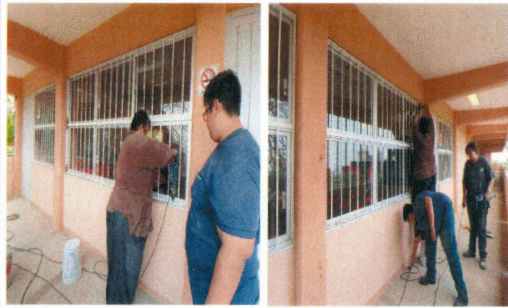
F15: Suministro y colocación de protecciones de herrería en aulas del edificio 10.
