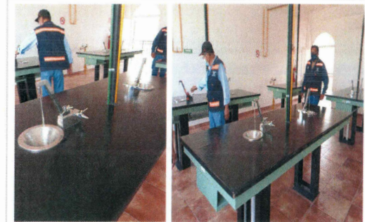
F34: Pruebas hidráulicas en mesas de laboratorio
