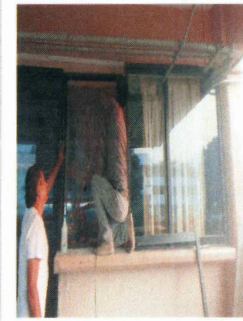
F7: Recorte y recolocación de cancelería duranodik existente en auditorio
