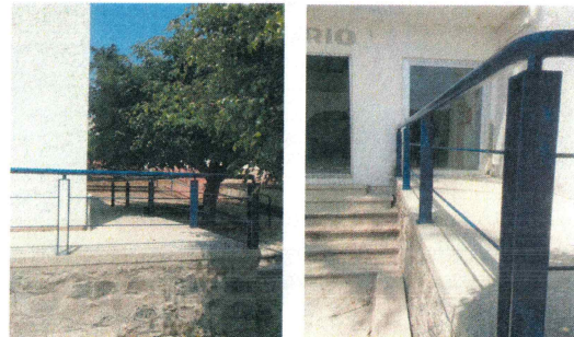
F9: Colocación de barandal de herrería con aplicación de pintura.
