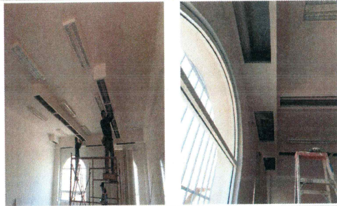
F23: Colocación de cajillo de tablaroca para cubrir tuberías sanitarias
