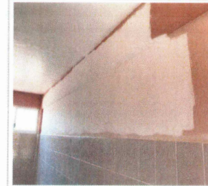
F10: Aplicación de pintura vinílica color blanco en muros y plafón en sanitario de hombres
