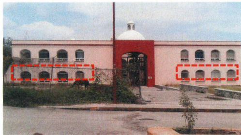
F1: Colocación de Protecciones de herrería en ventanas. Fachada Principal.
