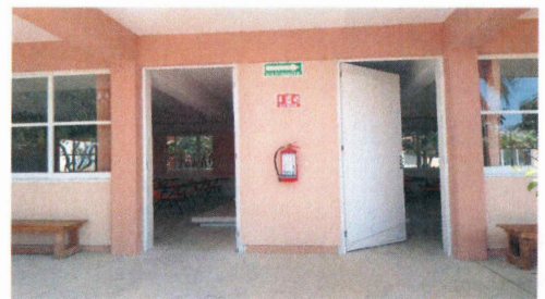
F19: Suministro y colocación de puertas tipo capfoc en aulas.
