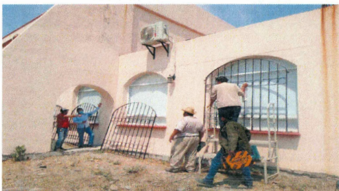
F12: Suministro y colocación de protecciones de herrería
