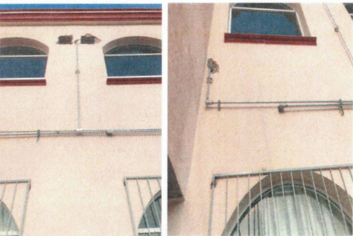
F38: Suministro y colocación de tuberías para instalaciones eléctricas
