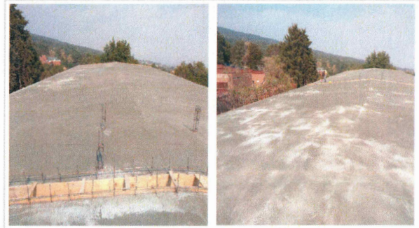
F29: Colado con concreto premezclado f'c = 250 \text{ kg/cm}^2 en losa de azotea
