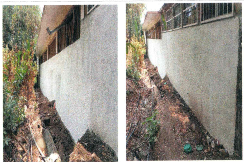
F22:Aplanado con mortero acabado fino con impermeabilizante integral.
