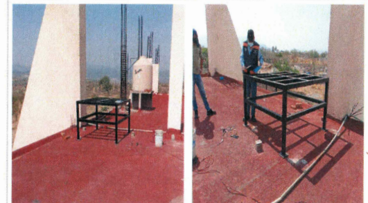
F19: Suministro y colocación de base de herrería para tinaco
