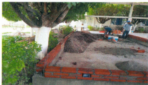
F14: Construcción de muros de tabique rojo para templete.
