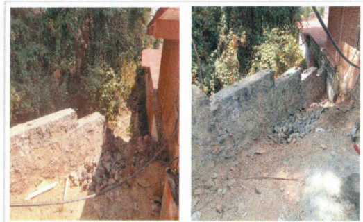
F13: Elaboración de muro de contención en límites de barranquilla
