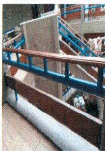
F7: Suministro y colocación de pasamanos de madera sobre solera
