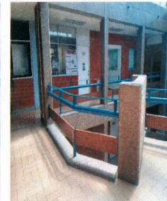
F6: Aplicación de pintura esmalte sobre solera en barandal existente para colocación de pasamanos de madera
