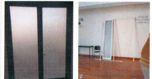
F14: Desmontaje de puerta de aluminio existente en auditorio
