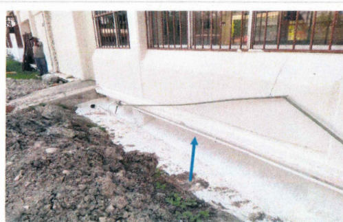
F29: Impermeabilización de cimentación en exterior de auditorio.
