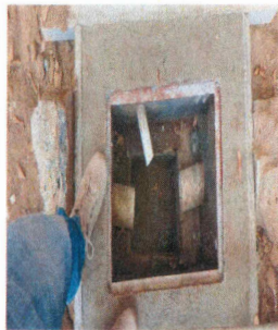
F15: Conexión de registros sanitarios y relleno.
