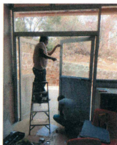
F4: Suministro y colocación de puerta de aluminio natural para salida de emergencia
