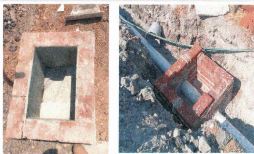
F6: Construcción de registros sanitarios de tabique rojo recocido
