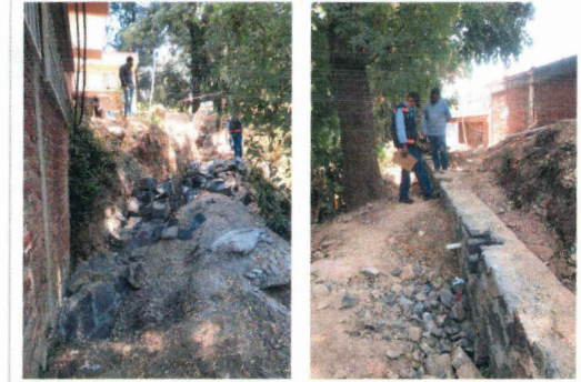
F7: Elaboración de muro de contención en límites de barranquilla
