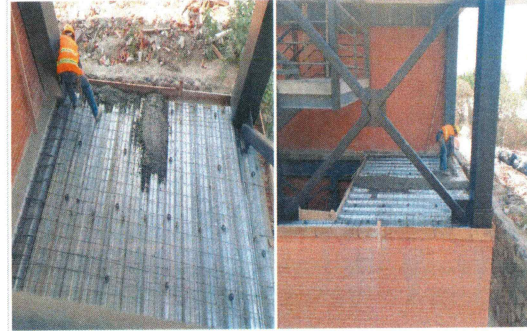
F40: Colado con concreto hecho en obra de losa de site
