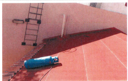
F10: Aplicación de sistema impermeable prefabricado
