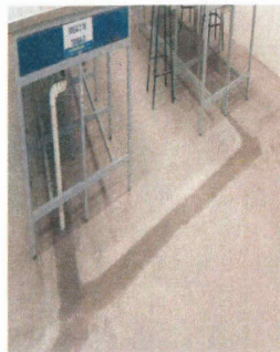
F16: Conexión de desagüe de mesas y colado de firme. Adecuación sanitaria para mesa de laboratorio.
