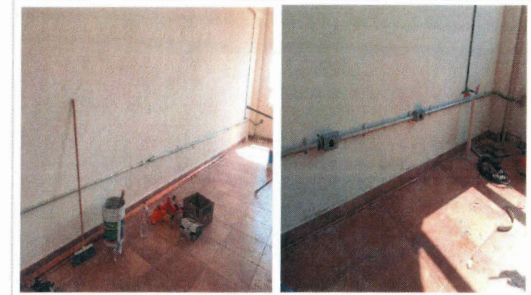
F16: Colocación de tubería de conduit para instalación eléctrica
