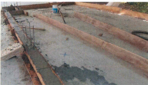
F8: Colado de cadena perimetral con concreto hecho en obra de templete en explanada.
