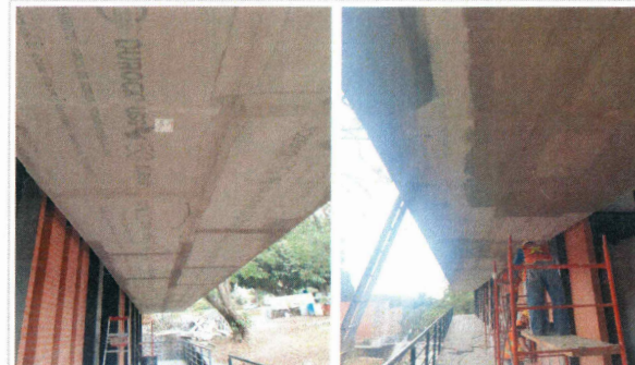
F44: Aplicación de pasta basecoat sobre plafón de durock en pasillos
