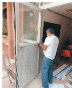
F4: Suministro y colocación de puerta de aluminio natural para salida de emergencia
