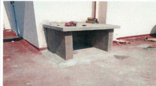
F18: Construcción de nicho para presurizador
