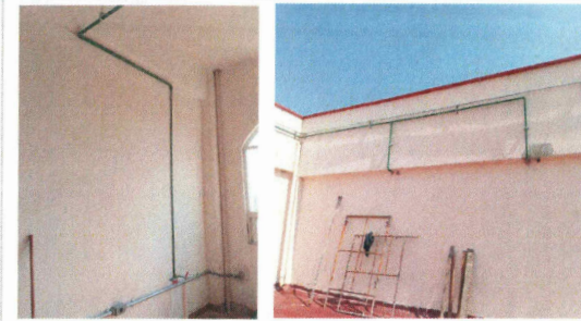
F15: Colocación de tubería de cobre para instalación hidráulica
