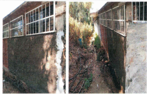
F14: Aplanado con mortero acabado fino con impermeabilizante integral
