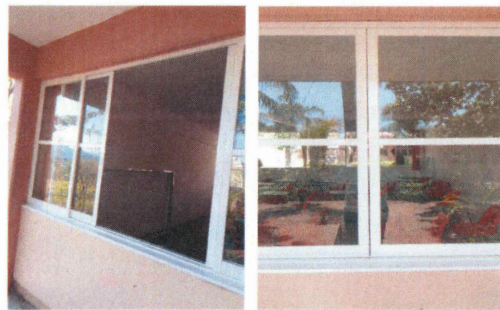
F16: Suministro y colocación de cancelería de aluminio de 2" en edificio 2.
