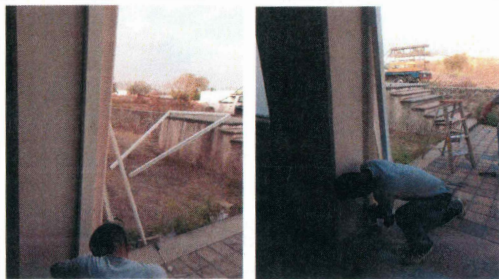
F15: Desmontaje de puerta de aluminio existente en auditorio
