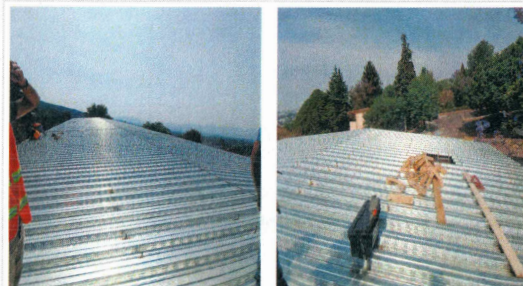
F4: Colocación de lámina losacero en azotea
