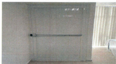
F16: Suministro y colocación de puerta de aluminio blanco con barra antipánico para salida de emergencia.
