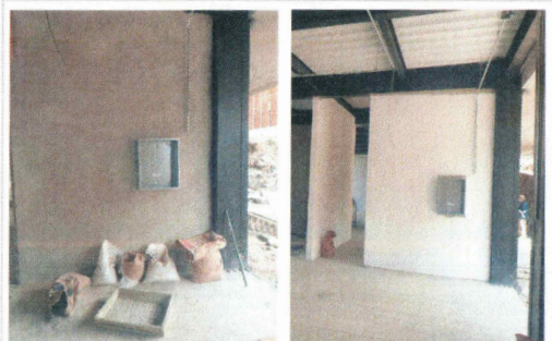
F48: Colocación de base de tablero eléctrico en planta baja
