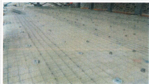
F3: Tendido de malla electrosoldada para firme de planta baja
