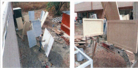
F30: Suministro y aplicación de pintura esmalte de mamparas de herrería de sanitarios
