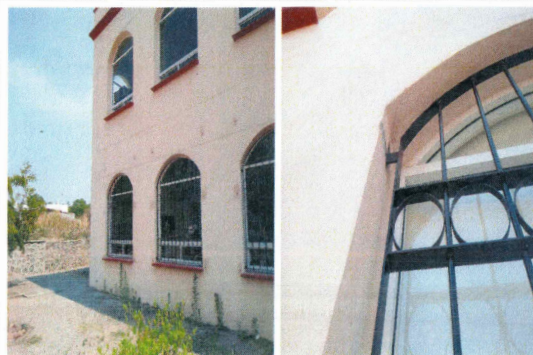
F20: Suministro y colocación de protecciones de herrería
