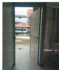
F14: Suministro y colocación de puerta de aluminio blanco con barra antipánico para salida de emergencia
