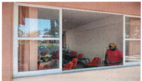
F13: Desmontaje por medios manuales de ventanas de aluminio en edificio 2
