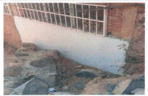
F11: Aplanado con mortero acabado fino con impermeabilizante integral
