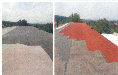
F54: Aplicación de primer y colocación de impermeabilizante de tapeto color terracota en losa de azotea
