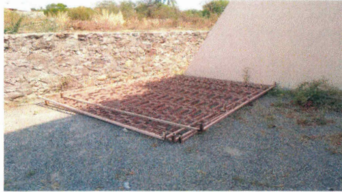
F6: Desmontaje de protecciones de herrería existentes con recuperación
