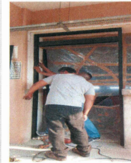
F6: Suministro y colocación de puerta de aluminio duranodik para salida de emergencia de auditorio
