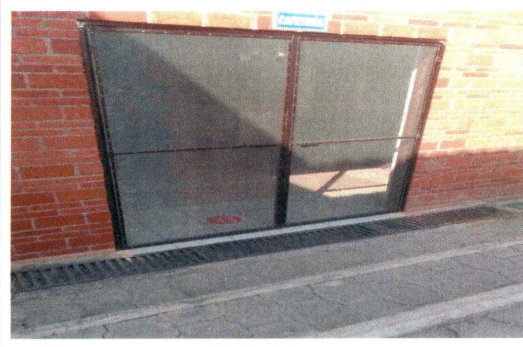
F18: Suministro, Fabricación y colocación de puerta de Herreria con moquitero en cafeteria.
