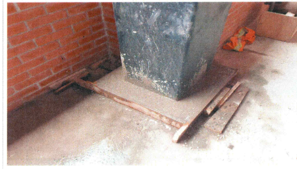
F59: Colado con concreto hecho en obra de bases de columnas para cubrir cartabones en planta baja
