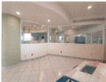
F13: Muros de tablaroca, con suministro y colocación de cancelería de aluminio.
