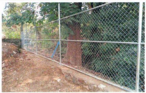
F19: Colocación de malla ciclónica perimetral sobre muro de contención
