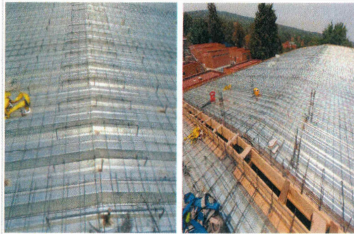
F15: Tendido de malla electrosoldada sobre lamina en azotea
