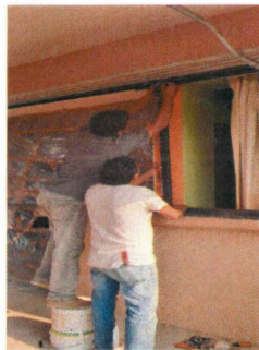
F5: Desmontaje de cancelería de aluminio duranodik existente con recuperación en auditorio
