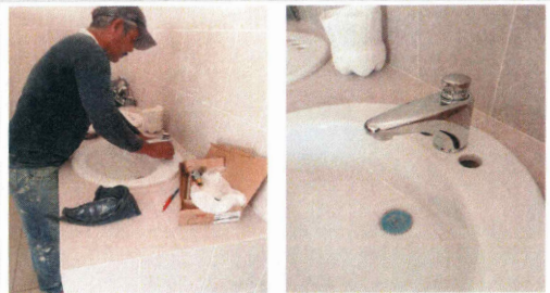
F20: Suministro y colocación de llave monomando para lavabos de sanitarios de hombres
