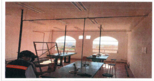
F7: Colocación de tubería de cobre para instalación hidráulica
