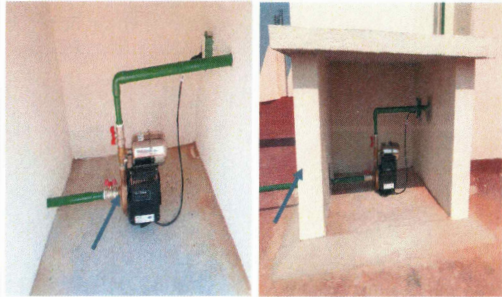
F41: Suministro, colocación y conexión de presurizador y Construcción de nicho.
