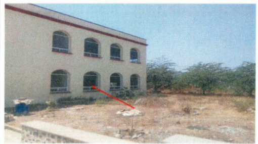
F3: Suministro y colocación de protecciones de herrería en vanos de fachadas P.B.
