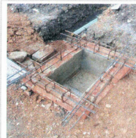
F15: Habilitado de acero para cadena perimetral de registro sanitarios.
