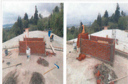
F45: Construcción de muros para base de tinacos en losa de azotea
