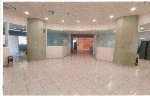
F14: Muros de tablaroca, con suministro y colocación de cancelería de aluminio.
