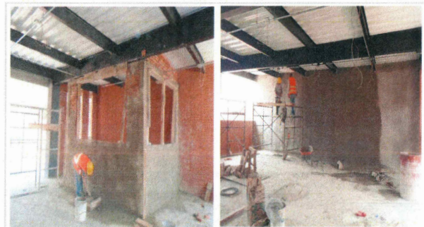
F23: Aplanado con mortero sobre muros divisorios de tabique rojo
