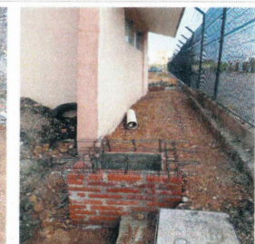
F15: Habilitado de acero para cadena perimetral de registro sanitarios.
