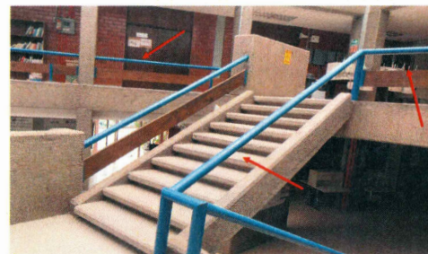
F2.- Módulo de escaleras - Sustitución de barandales existentes.
