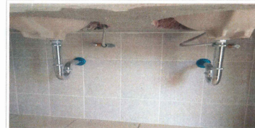
F28: Suministro y colocación de lavabos, llaves monomando y cespel en sanitario de mujeres
