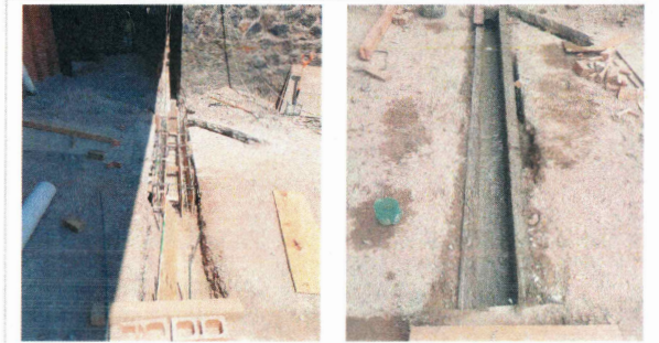
F32: Fojado de canal pluvial en perímetro de edificio
