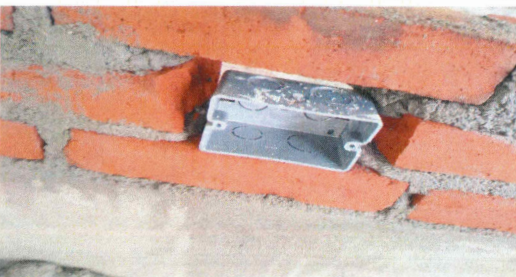
F12: Preparaciones eléctricas en muros de tabique de templete.
