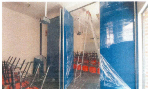
F11: Suministro y colocación de muro móvil
