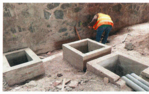
F25: Construcción de registros eléctricos y para voz y datos
