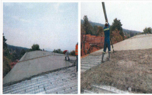
F28: Colado con concreto premezclado f'c = 250 \text{ kg/cm}^2 en losa de azotea
