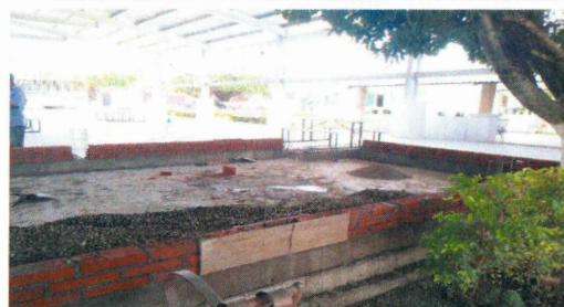
F15: Construcción de muros de tabique rojo para templete.
