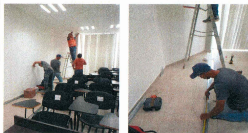
F9: Recorte y demolición de muro de tablaroca existente
