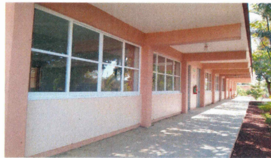
F17: Suministro y colocación de cancelería de aluminio de 2" en edificio 2.
