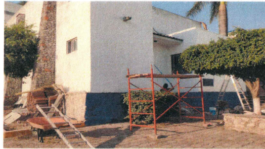
F5: Suministro y aplicación de pintura vinílica en fachada de auditorio
