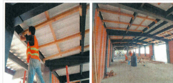
F5: Colocación de cimbra en lecho bajo de losa de azotea
