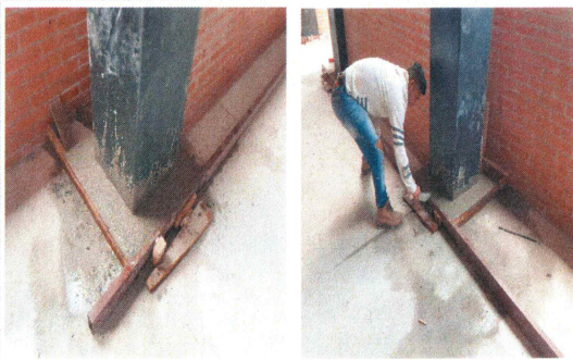
F58: Colado con concreto hecho en obra de bases de columnas para cubrir cartabones en planta baja
