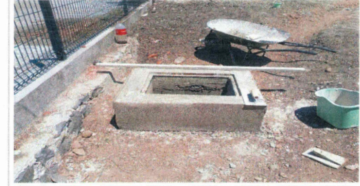
F19: Colado con concreto hecho en obra de cadena perimetral de registros sanitarios
