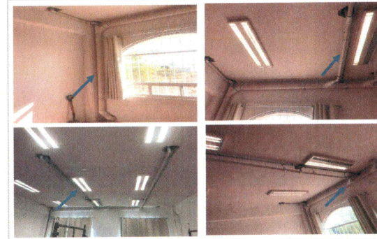
F27: Suministro y colocación de tubería de pvc para instalaciones sanitarias y tubería conduit para instalaciones eléctricas.
