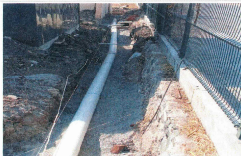
F5: Tendido de tubería de pvc sanitario
