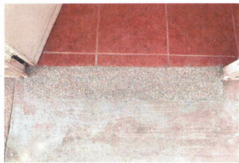
Colado de cenefa de concreto deslavado en acceso de puertas a aulas por cambio de nivel
