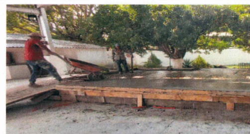
F19: Colado de firme con concreto hecho en obra de templete.
