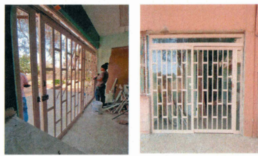
F10: Suministro y colocación de puerta protección de herrería en acceso.
