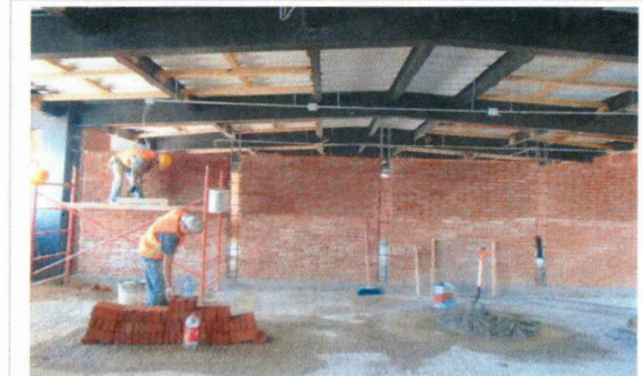
F20: Muros de tabique rojo recocido en divisiones de aulas
