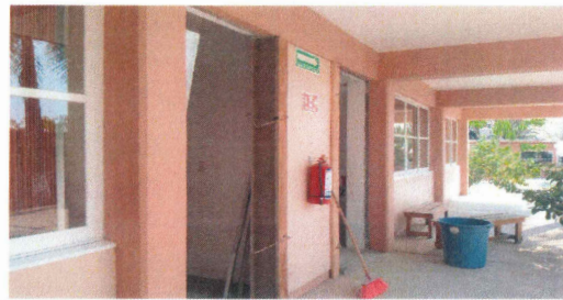
F8: Boquillas en vanos de puertas de aulas
