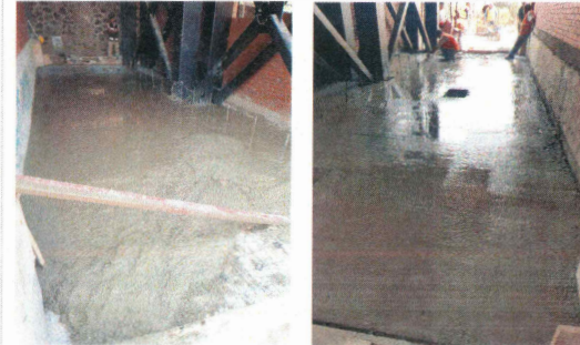
F31: Colado con concreto hecho en obra de firme de pasillo en planta baja
