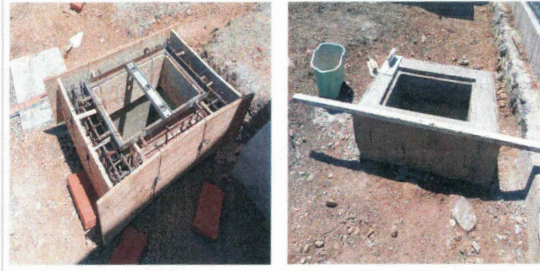
F18: Habilitado de cimbra y colado con concreto hecho en obra de cadena perimetral de registros sanitarios
