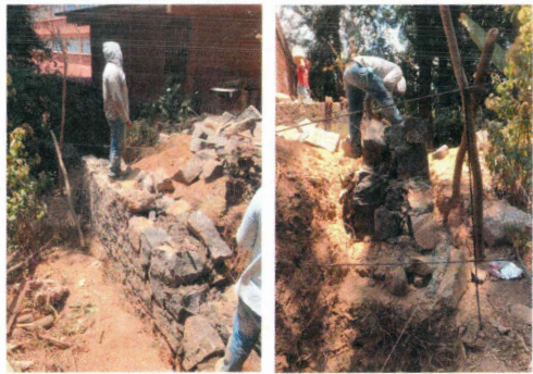
F6: Elaboración de muro de contención en límites de barranquilla
