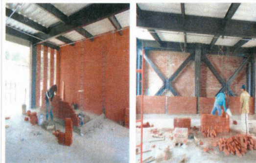
F16: Muros de tabique rojo recocido en divisiones de aulas
