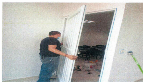
F12: Suministro y colocación de puerta de aluminio blanco con barra antipánico para salida de emergencia.
