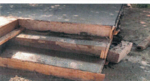
F21: Colado de escalones con concreto hecho en obra de templete.
