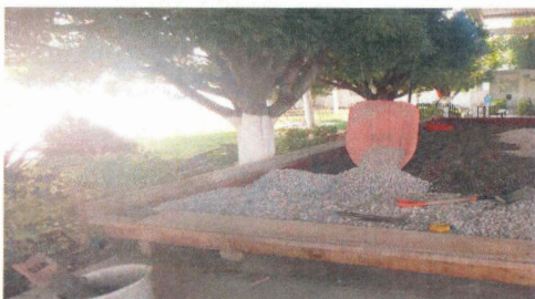
F17: Suministro y tendido de material de relleno en interior de muros de templete.
