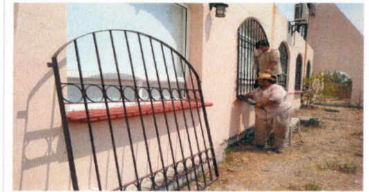
F11: Suministro y colocación de protecciones de herrería
