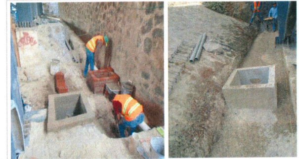
F11: Construcción de registros eléctricos y para voz y datos
