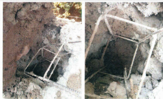
F12: Colado de castillos ahogados con concreto hecho en obra
