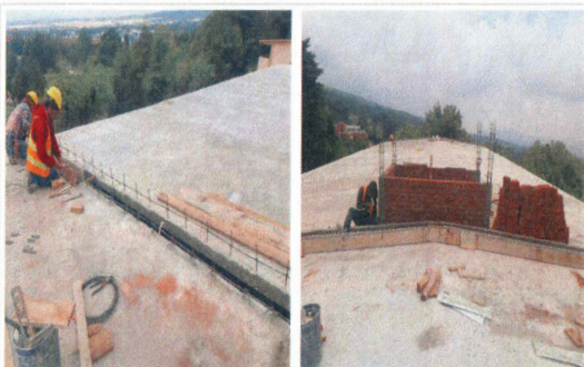
F46: Habilitado de acero y cimbra en junta constructiva de losa de azotea
