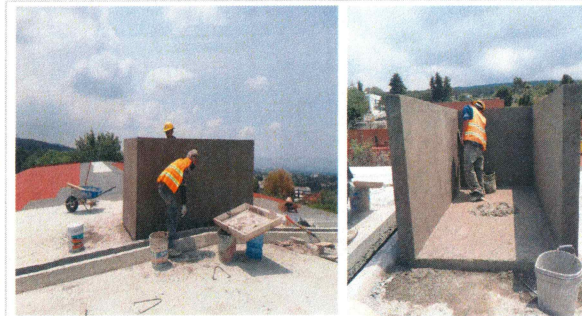
F56: Aplanado con mortero de muros de tabique rojo de base de tinacos
