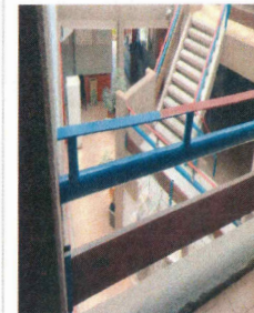
F6: Aplicación de pintura esmalte sobre solera en barandal existente para colocación de pasamanos de madera
