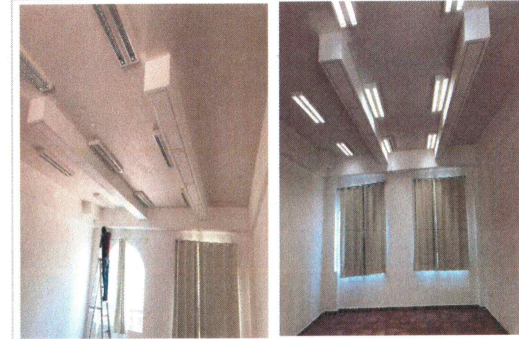
F28: Colocación de cajillo de tablaroca para cubrir tuberías sanitarias
