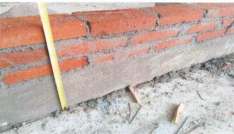
F11: Construcción de muros de tabique rojo para templete.
