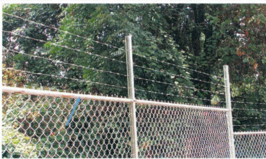
F20: Colocación de malla ciclónica perimetral sobre muro de contención
