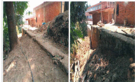
F10: Elaboración de muro de contención en límites de barranquilla
