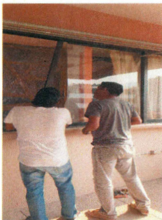
F5: Desmontaje de cancelería de aluminio duranodik existente con recuperación en auditorio
