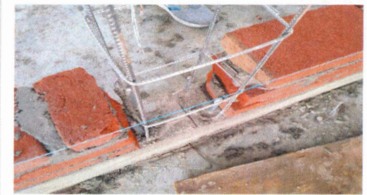
F10: Construcción de muros con tabique rojo y anclaje de castillo a cadena perimetral.
