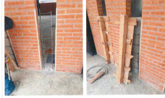
F37: Habilitado de acero y cimbra en troneras de muros
