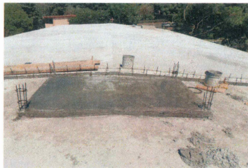
F42: Colado con concreto hecho en obra de base para tinacos en azotea
