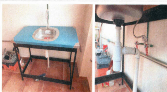
F21: Suministro, colocación y conexión de mesa de lavado
