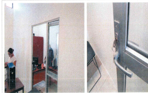
F12: Suministro y fabricación de muro de tablaroca en centro de computo y Suministro y fabricación de puerta de aluminio anodizado natural.
