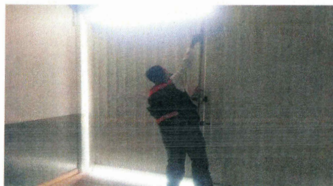
F3: Adecuación a la salida de emergencia suministrando barra antipánico que funcionen y rehabilitando las puertas.
