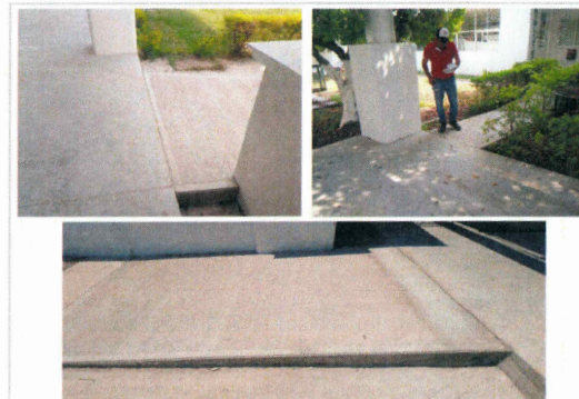
F35: Colado de rampas con concreto hecho en obra en explanada.
