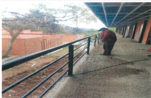
F51: Aplicación de pintura esmalte en barandal perimetral de pasillo
