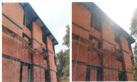
F52: Colocación de muro vinyl en union de losas de entrepiso (fachada sur)
