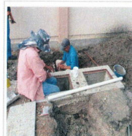
F16: Conexión sanitaria de tubería existente a registro
