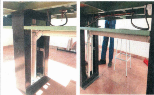
F39: Conexión de instalación hidráulica en mesas de laboratorio
