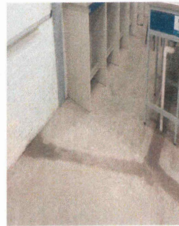
F16: Conexión de desagüe de mesas y colado de firme. Adecuación sanitaria para mesa de laboratorio.
