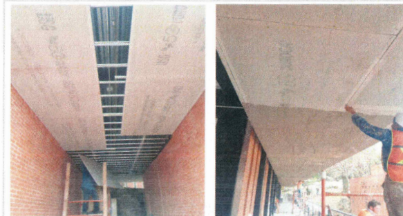
F50: Colocación de plafón de durock y aplicación de pasta basecoat
