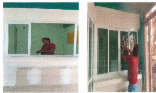
F13: Suministro y colocación de ventanas de aluminio blanco en oficinas.
