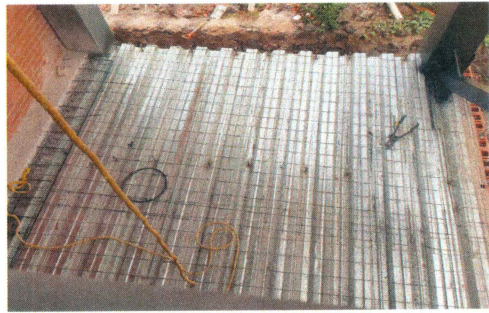
F33: Tendido de malla electrosoldada para losa de site
