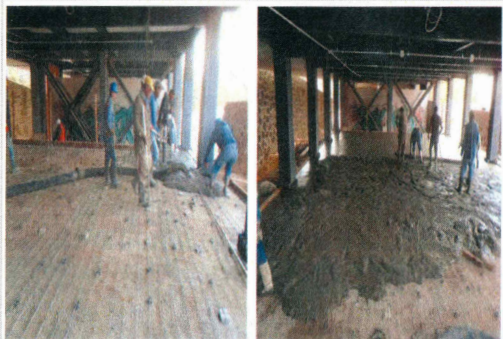
F18: Colado de firme con concreto premezclado f_c = 250 \text{ kg/cm}^2 en planta baja
