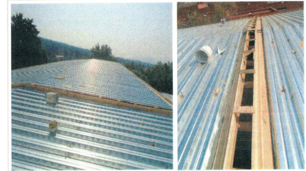
F14: Habilitado de cimbra perimetral en losa de azotea
