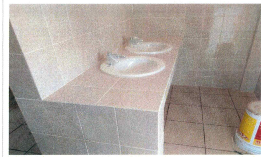
F37: Suministro y colocación de lavabos, llaves monomando y cespel en sanitario de mujeres y hombres.
