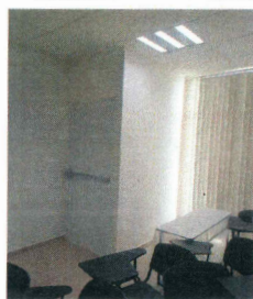
F13: Suministro y colocación de puerta de aluminio blanco con barra antipánico para salida de emergencia. Suministro y colocación de muro de tablaroca
