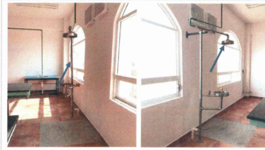
F36: Colocación de regadera mixta con lavajos.
