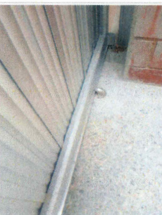
F10: Suministro y colocación de botaguas y topes de puerta de salida de emergencia
