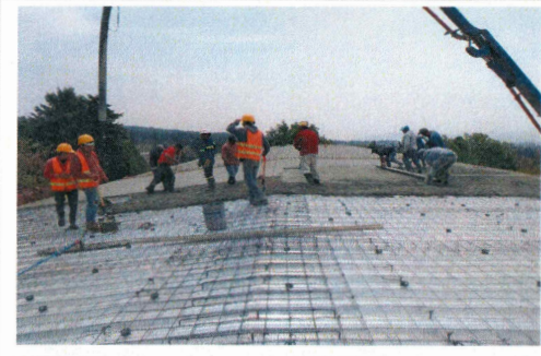
F27: Colado con concreto premezclado f'c = 250 \text{ kg/cm}^2 en losa de azotea
