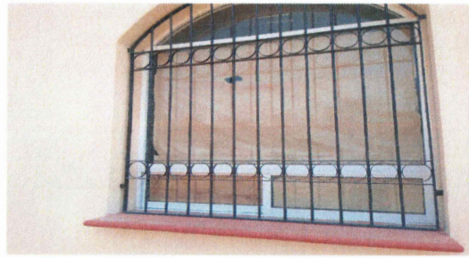
F19: Suministro y colocación de protecciones de herrería.
