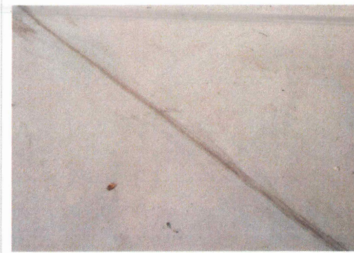
F32: Calafateo de junta de dilatación en piso de explanada.
