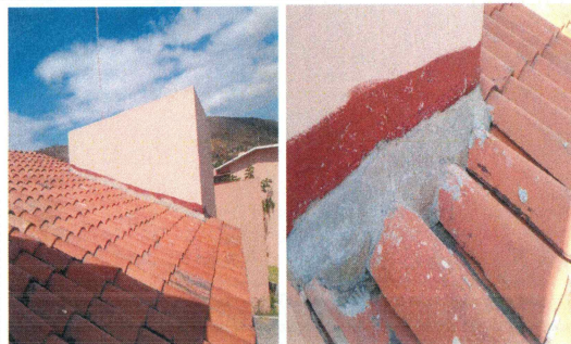
F11: Chaflán de concreto F'_{cd} = 100 \text{ kg/m}^2 y colocación de teja de barro.
