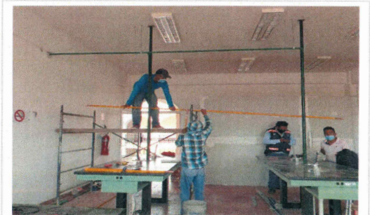
F13: Colocación de tubería de cobre para instalación de gas
