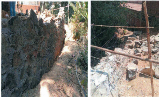
F9: Elaboración de muro de contención en límites de barranquilla
