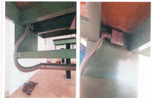
F40: Conexión de instalación eléctrica en mesas de laboratorio
