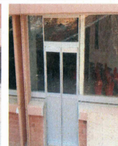
F9: Adecuación de cancelería y colocación de puerta de emergencia
