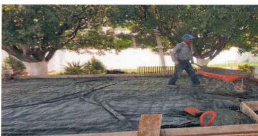
F18: Colocación de polietileno y tendido de malla electrosoldada.
