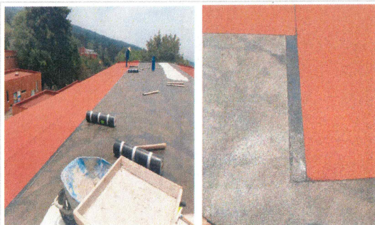
F55: Aplicación de primer y colocación de impermeabilizante de tapeto color terracota en losa de azotea
