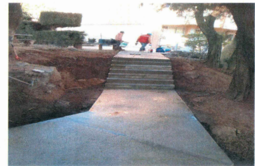
F18: Corte, afine de terreno y colado de andador para acceso a Dirección de la Facultad de Diseño.
