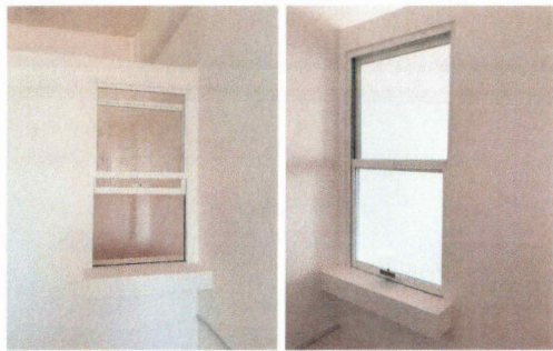
F32: Suministro y colocación de ventana de aluminio blanco sobre muro de tablaroca
