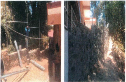
F17: Colocación de postes de soporte de malla ciclónica
