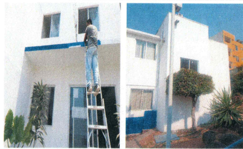
F4: Suministro y aplicación de pintura vinílica en fachada de auditorio
