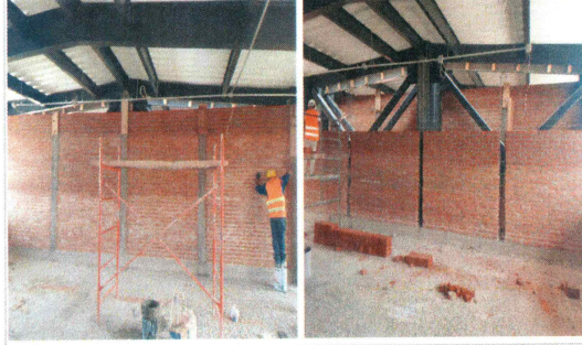
F34: Muros de tabique rojo recocido en divisiones de aulas
