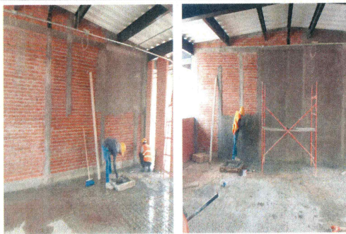
F39: Aplanado con mortero sobre muros divisorios de tabique rojo
