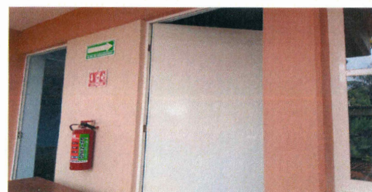
F20: Suministro y colocación de puertas tipo capfoc en aulas.
