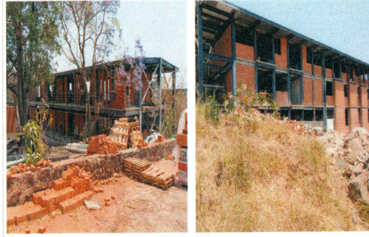
F7: Muros de tabique vintex en fachadas
