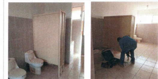
F31: Colocación de mamparas de herrería en sanitario de mujeres.
