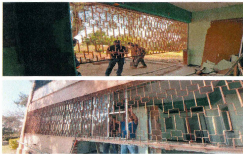
F9: Recorte y desmontaje de protección de herrería existente.
