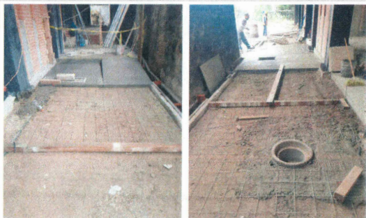
F49: Colado con concreto hecho en obra de firme de pasillo y rampa en planta baja
