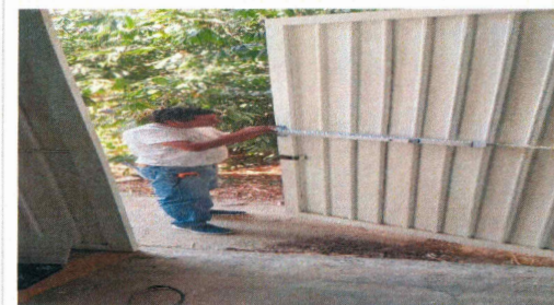
F11: Suministro y colocación de barra antipánico en puerta de herrería
