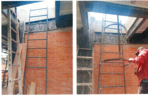
F36: Colocación de escalera marina de paso a azotea
