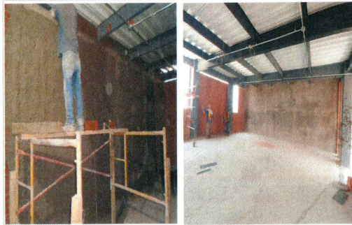
F9: Aplanado con mortero sobre muros divisorios de tabique rojo
