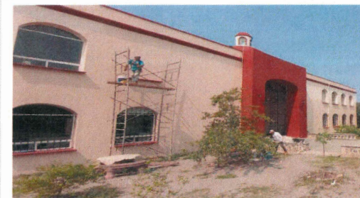
F17: Aplicación de pintura vinílica en muros de fachada principal
