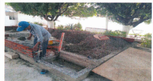
F13: Construcción de muros de tabique rojo para templete.
