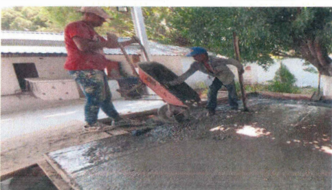
F20: Colado de firme con concreto hecho en obra de templete.
