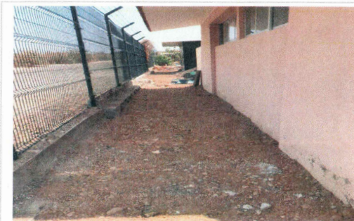
F7: Relleno y compactación de terreno en área de excavación
