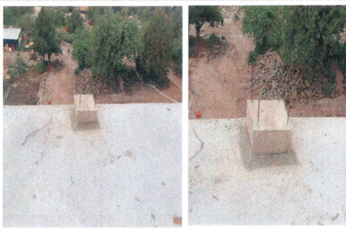
F57: Colado con concreto hecho en obra de base de pararrayos en losa de azotea
