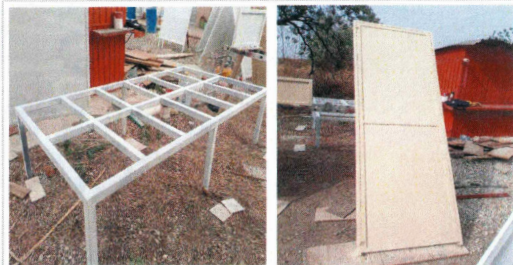
F29: Suministro de base para tinacos y puerta de herrería para cuarto de servicio
