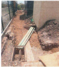
F8: Relleno y compactación de terreno en área de excavación
