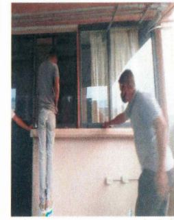
F7: Recorte y recolocación de cancelería duranodik existente en auditorio
