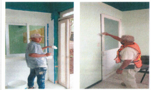
F14: Suministro y aplicación de pintura vinílica sobre muros.
