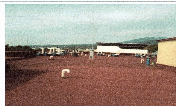
F22: Aplicación de impermeabilizante acrílico
