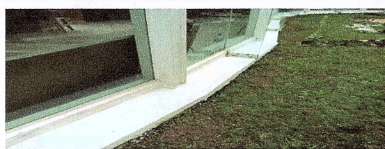
F30: Suministro y colocación de impermeabilizante acrílico con membrana
