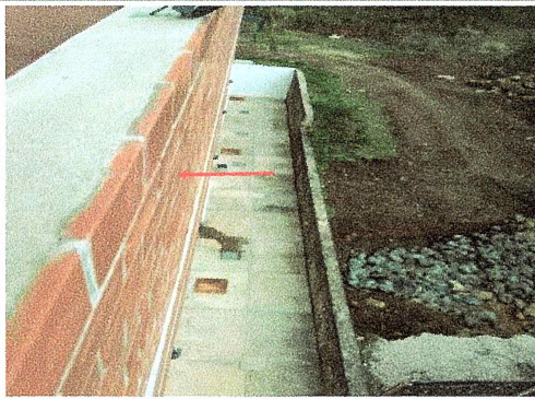
F6: Mantenimiento al sistema de impermeabilización existente del edificio No. A 70. Impermeabilización de Muros Exteriores, Fachada Este.
