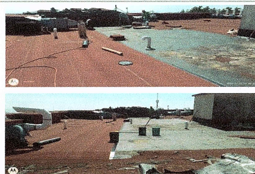
F18: Suministro y colocación de impermeabilizante de tapete
