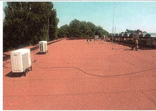
F16: Impermeabilizante acrílico como mantenimiento al existente
