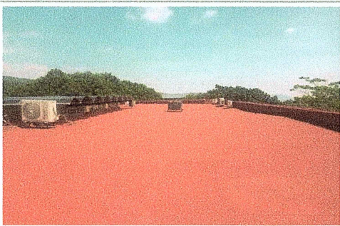
F18: Impermeabilizante acrílico como mantenimiento al existente
