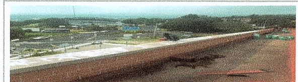
F8: Suministro y aplicación de impermeabilizante acrílico como mantenimiento al existente
