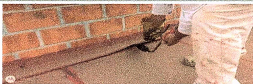
F6: Mantenimiento al sistema de impermeabilización existente del edificio No. A 70. Impermeabilización de Muros Exteriores, Fachada Este.
