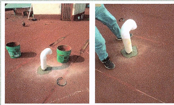
F10: Suministro y colocación de tubo ventila
