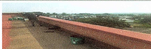
F7: Sellado de juntas de impermeabilizante existente
