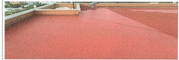
F8: Suministro y aplicación de impermeabilizante acrílico como mantenimiento al existente
