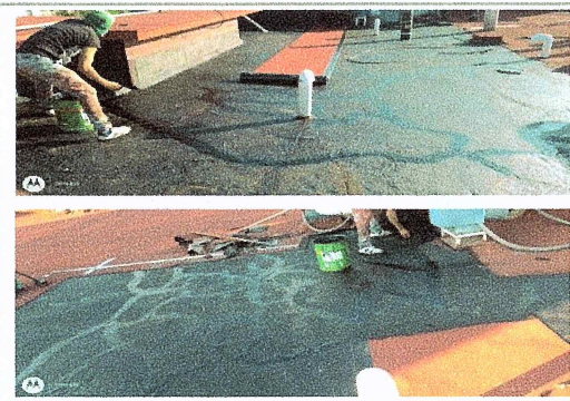
F11: Sellado de juntas con cemento plastico
