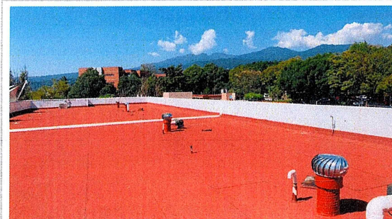
F11: Extractores de laboratorios LB-01, LB-02, LB-03 y LB-04, equipados con extractores atmosféricos.
