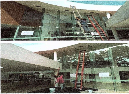
F32: Suministro y aplicación de pintura vinílica en fachada principal
