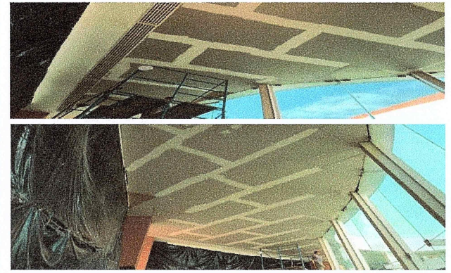
F34: Suministro y colocación de plafón liso de tablaroca
