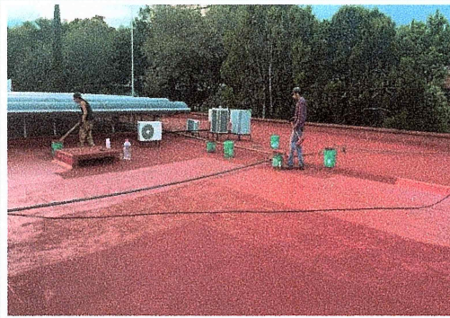
F14: Suministro y aplicación de impermeabilizante acrílico como mantenimiento al existente
