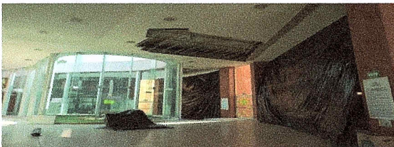
F27: Desmontaje de plafón existente dañado
