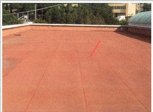
F3: Mantenimiento al sistema de impermeabilización existente del edificio No. A 70. Cubierta de azotea, fachada suroeste del edificio.
