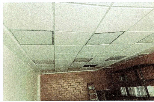
F17: Arreglo de plafon modular de 61 x 61 cm dañado
