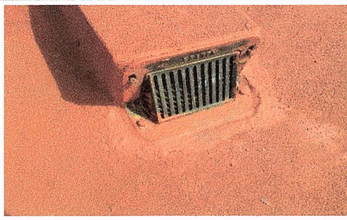
F24: Desmontaje y recolocación de coledera para nivelación.
