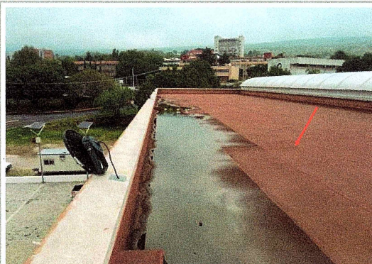
F4: Mantenimiento al sistema de impermeabilización existente del edificio No. A 70. Cubierta de azotea, fachada suroeste del edificio.
