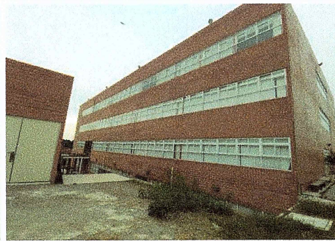
F19: Mantenimiento de impermeabilizante de muros exteriores y modificación de cancelería de aluminio, de louver a corredizos en planta baja y primer nivel fachada norte
