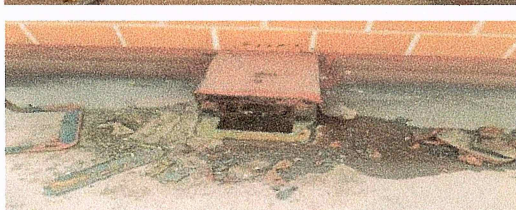
F11: Desmontaje y recolocación de coladeras para nivelación
