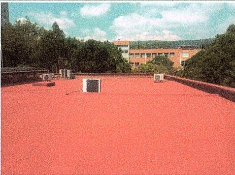
F15: Impermeabilizante acrílico como mantenimiento al existente
