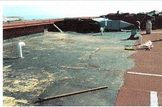
F15: Desprendimiento de impermeabilizante existente dañado
