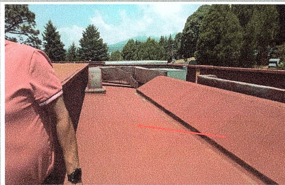
F4: Adecuación y Mejoras de la Cubierta y "Huerto Solar" en la Biblioteca Central. Trabajos de impermeabilización en losa de azotea y pretil, colocación de huerto solar, Nave principal
