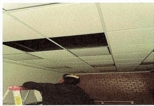
F16: Arreglo de plafon modular de 61 x 61 cm dañado
