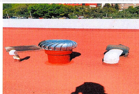
F13: Laboratorio B-02, equipado con extractores atmosféricos.
