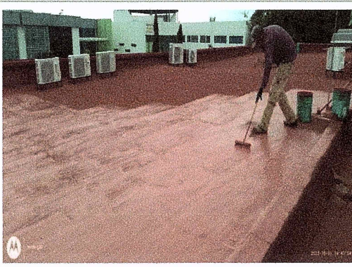
F11: Suministro y aplicación de impermeabilizante acrílico como mantenimiento al existente
