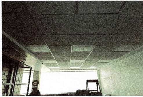
F21: Arreglo de plafón modular de 61 x 61 cm dañado
