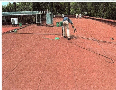
F7: Sellado de juntas de impermeabilizante existente
