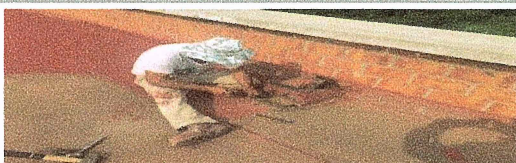
F8: Suministro y aplicación de impermeabilizante acrílico como mantenimiento al existente
