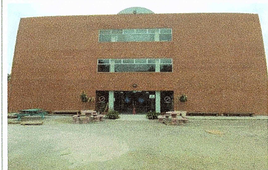
F20: Modificación de cancelería de aluminio, de louver a corredizos en primer y segundo nivel fachada poniente
